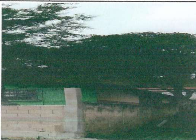
Foto 2: PINTURA DE MUROS EXTERIORES E INTERIORES
