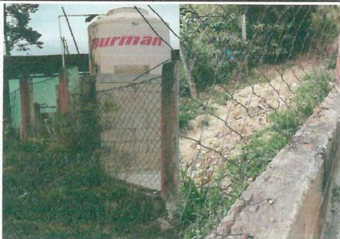
Foto 1: REPARACION DE CERCO PERMETRAL CON MALLA
